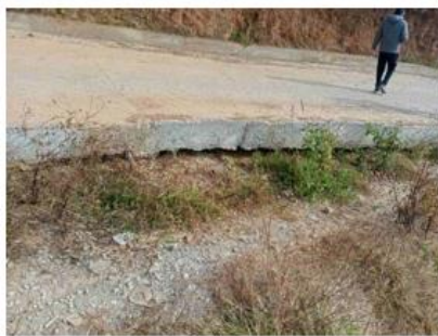
निर्माण सम्पन्न पश्चात माटो फिल गर्नुपर्ने देखिएको
